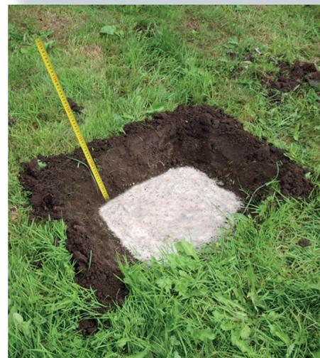
Füllen Sie die Löcher mit Beton, sodass eine Tiefe von z.B. 25/40 cm / 10"/16" (siehe die nächsten Seiten) über dem Beton entsteht. Lassen Sie den Beton für ca. 6-7 Tage trocknen.
