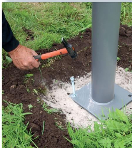
Befestigen Sie die Schwerlastdübel M12/M16.
