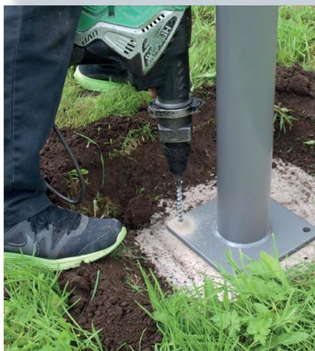
Bohren Sie Löcher mit einem Bohrhämmer.
