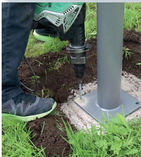
Bohren Sie Löcher mit einem Bohrhämmer.
