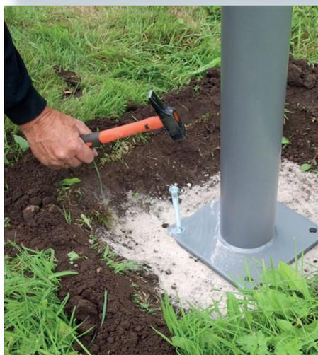
Befestigen Sie die Schwerlastdübel M20.
