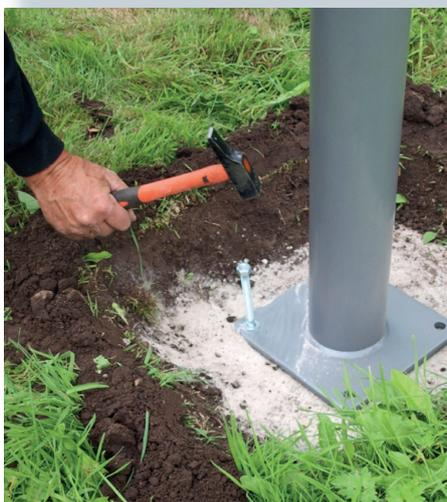
Befestigen Sie die Schwerlastdübel M12/M16.
