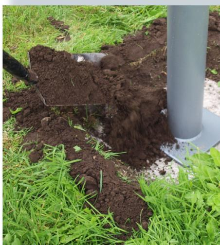
Stellen Sie sicher, dass die Fitness Station stabil und fest fixiert ist bevor sie mit Erde bis zur Oberfläche gefüllt wird.
