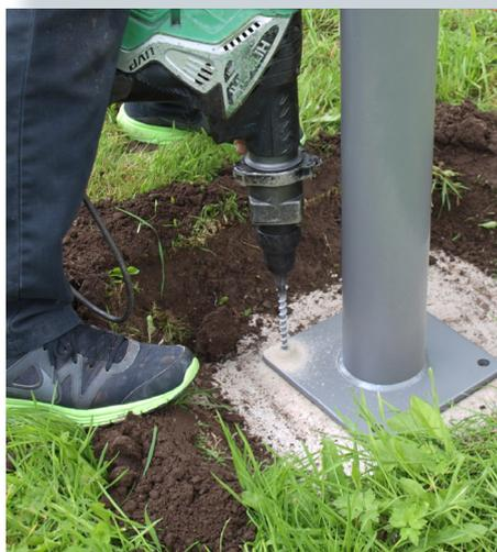
Bohren Sie Löcher mit einem Bohrhämmer.
