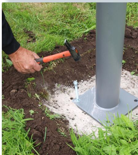
Befestigen Sie die Schwerlastdübel M12/M16.
