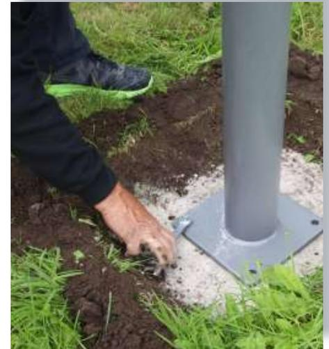
Spannen Sie die Schwerlastdübel mit einem Drehmoment bei M12 = 90 N/m und
