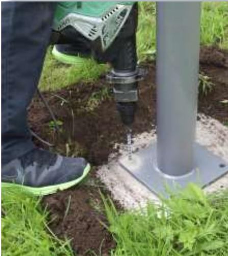
Bohren Sie Löcher mit einem Bohrhämmer.
