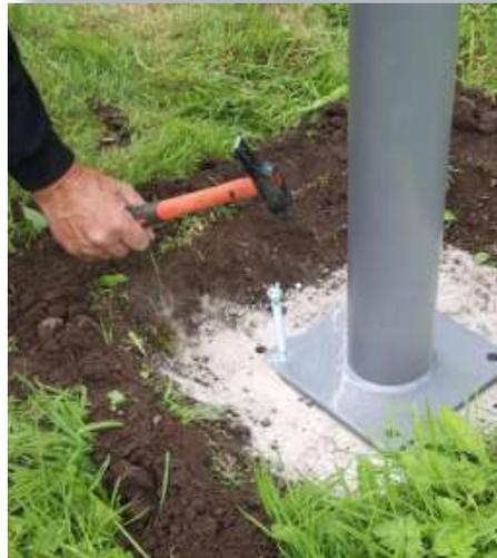
Befestigen Sie die Schwerlastdübel M12/M16.
