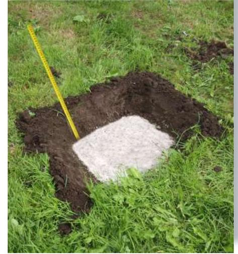
Füllen Sie die Löcher mit Beton, sodass eine Tiefe von z.B. 25/40 cm / 10"/16" (siehe die nächsten Seiten) über dem Beton entsteht.
