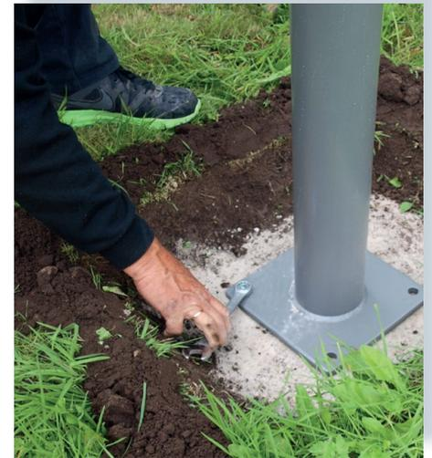
Spannen Sie die Schwerlastdübel mit einem Drehmoment bei M12 = 90 N/m und M16 = 120 N/m an.
