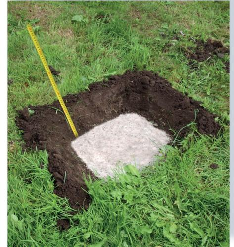
Füllen Sie die Löcher mit Beton, sodass eine Tiefe von z.B. 25/40 cm / 10"/16" (siehe die nächsten Seiten) über dem Beton entsteht. Lassen Sie den Beton für ca. 6-7 Tage trocknen.
