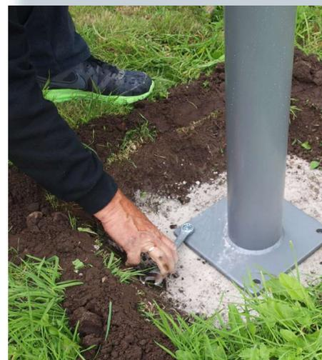
Spannen Sie die Schwerlastdübel mit einem Drehmoment bei M12 = 90 N/m und M16 = 120 N/m an.
