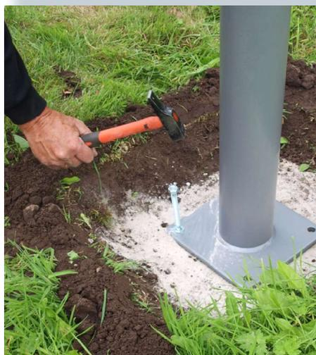
Befestigen Sie die Schwerlastdübel M12/M16.
